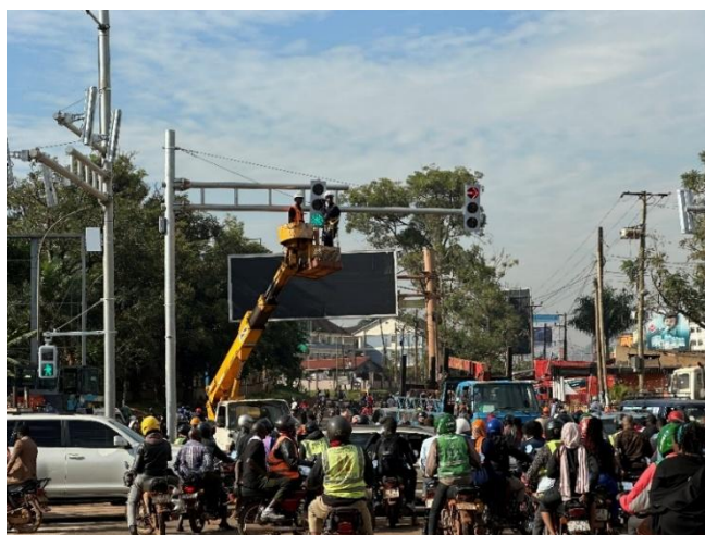
現地企業による設置工事（当社納入機器）
