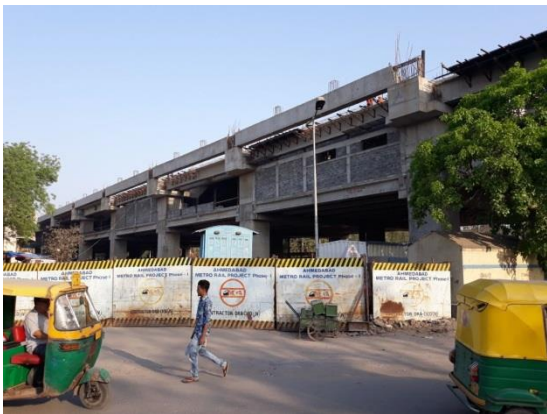
AFC システムが納入される駅舎の工事現場
