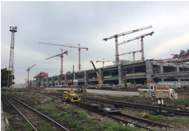
バンコクレッドライン建設現場の様子
