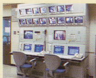
総合監視装置
